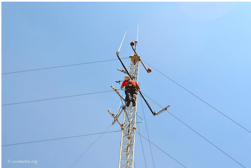
Moment de la instal·lació de l'estació meteorològica
